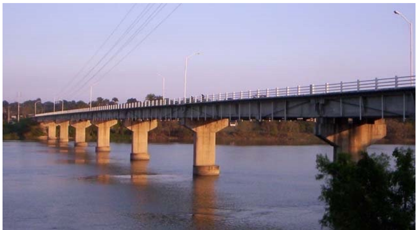
FOTOGRAFÍA: PUENTE TECOLUTLA FUENTE: https://mapio.net/pic/p-4332759/
